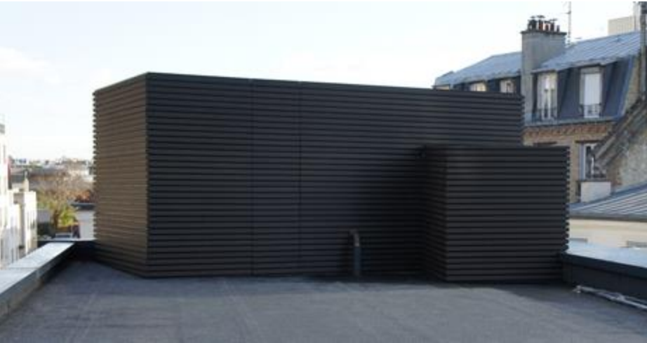
EXEMPLE DE CACHE CLIMATISATION EN TOITURE
